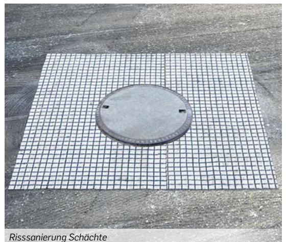
Sanierung Quartierstrasse Buchs AG
