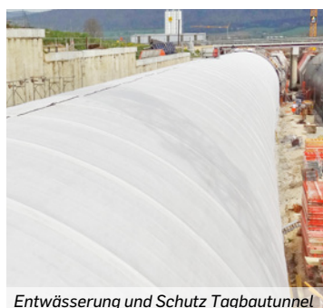
Entwässerung und Schutz Tagbautunnel
