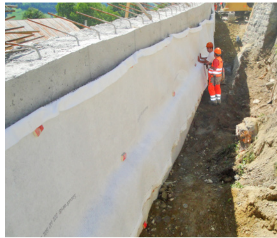
Entwässerung Stützmauer
