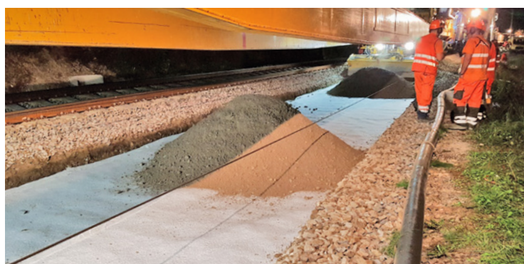
Kapillarsperre und Planumsentwässerung im Bahnbau
